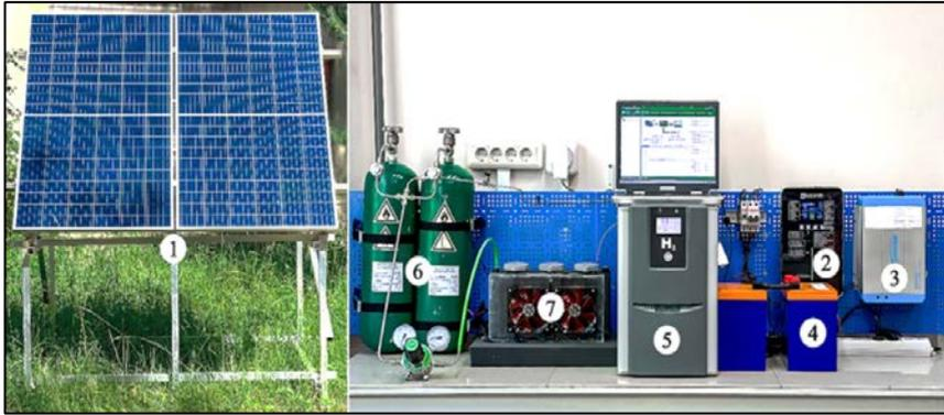
Рисунок 80 – Водородная система аккумулирования энергии: 1 – солнечные панели, 2 – контроллер, 3 – инвертор, 4 – батареи, 5 – генератор водорода, 6 – металлгидридный аккумулятор водорода, 7 – топливный элемент [89].
