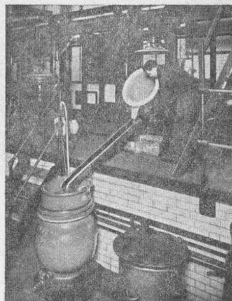
Фиг. 5. Разгрузка разварочного котла на фильтр.
